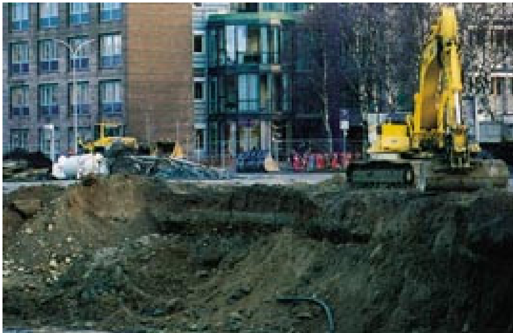
Medisinsk teknisk forskningssenter rommer Det medisinske fakultet samt flere forskningsinstitutter og teknologiske firmaer. I det store hullet i forgrunnen bygges en del av det nye regionsykehuset. Foto T. Sundar
